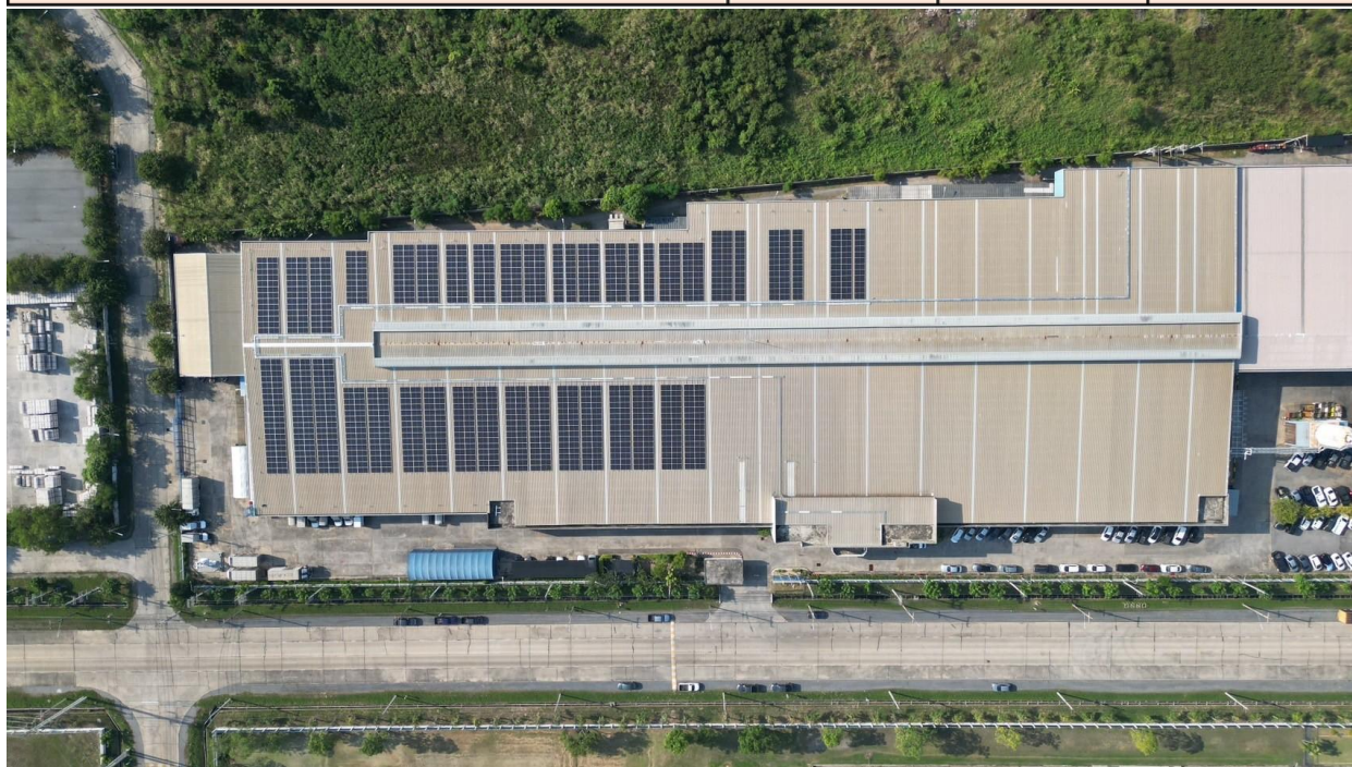
แสดงภาพการติดตั้ง Solar Rooftop ขนาด 653.39 kW บนหลังคาโรงงานบางปะอิน
